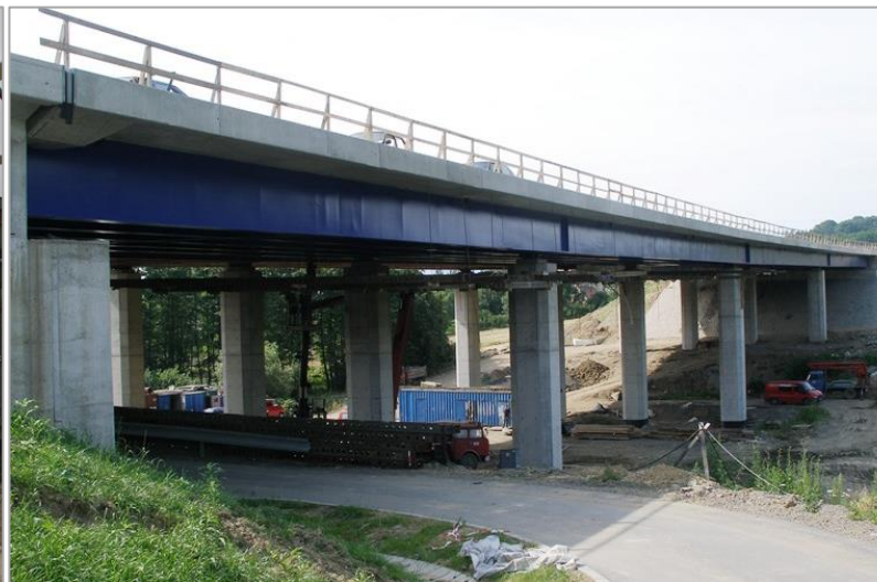
OK mostu přes Sadový - Český Těšín (Žukov)
