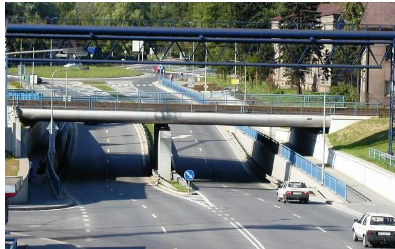
Železniční Most „Myší díra“, Třinec
