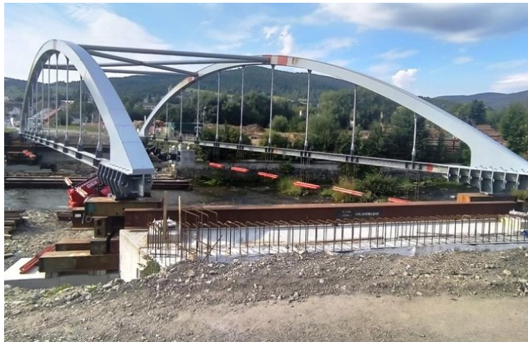
Most přes řeku Opavu - ve Vrbně pod Pradědem
