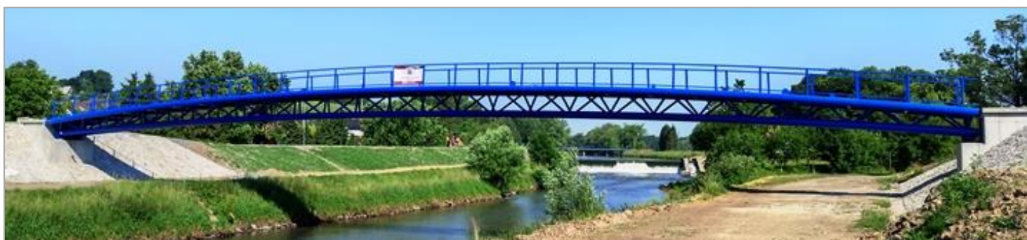
Přechodová lávka přes řeku Opava - u Hlučína
