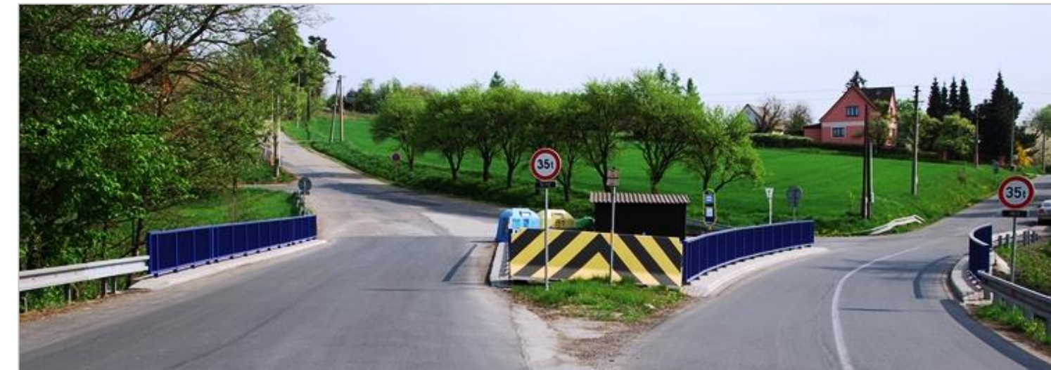
Mostky přes Staviska - Třinec
