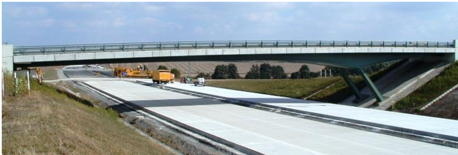
OK mostu – Těšice- Tišín
