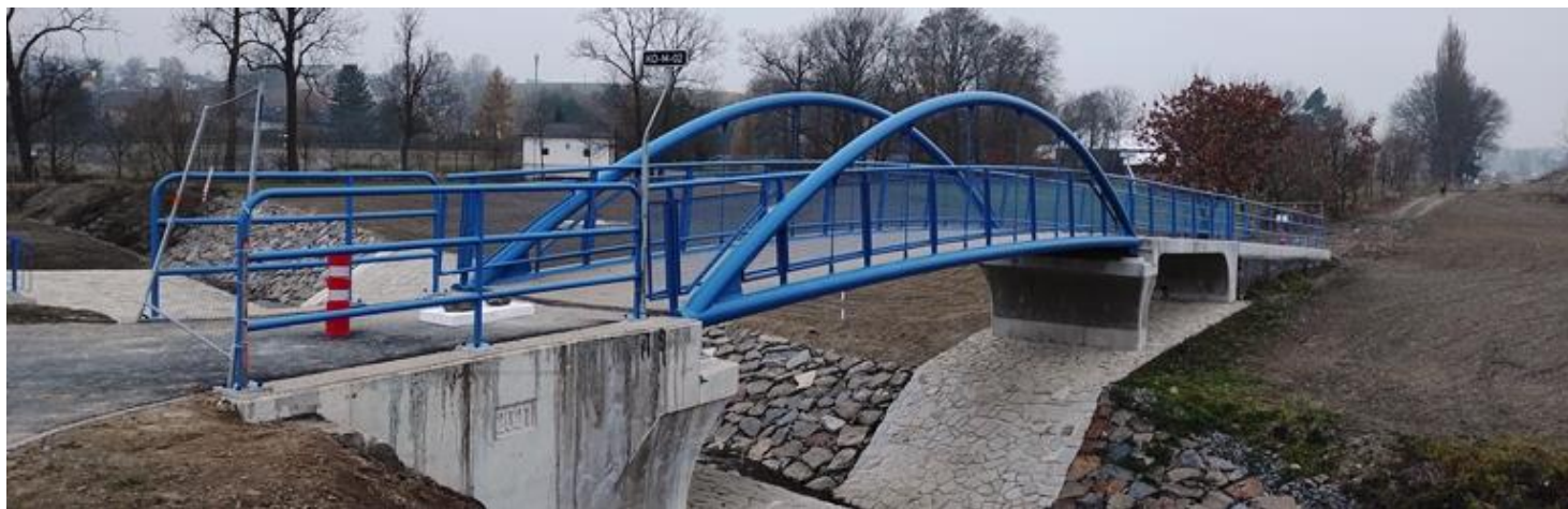
Přechodová lávka přes Juliánku - u Hlučína
