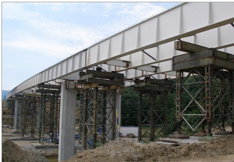
OK mostu přes Jasení - Jablunkov
