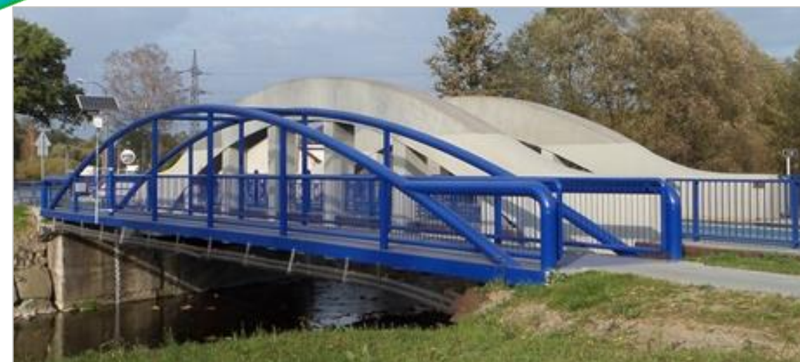
Přechodová lávka Ropice
